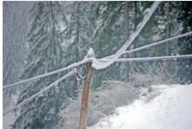
Električne in telefonske žice, vklejene v led / FOTO: TINA DOKL
